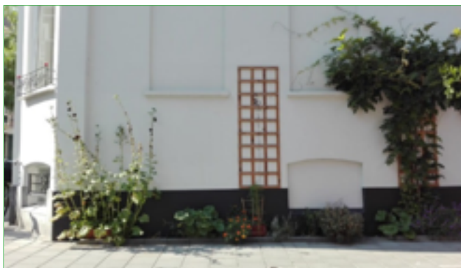
Een groen dak in Arnhem West © Arnhem AAN / Een net aangelegde geveltuin in het Spijkerviertel © Marleen Michels
